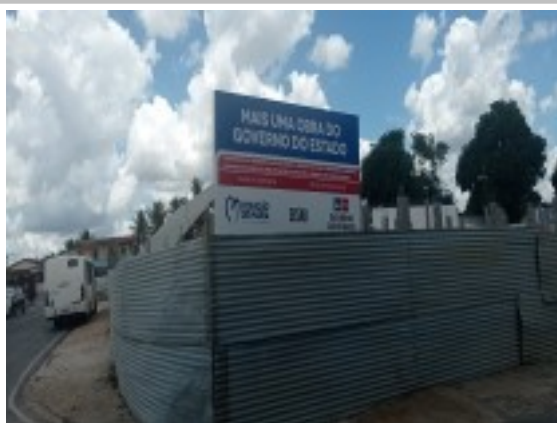
Placa de Identificação da Obra
