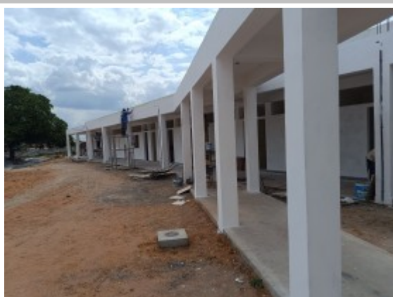
Vista externa, obras em execução
