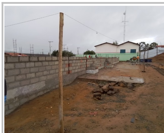
Obras em andamento (Vista lateral)
