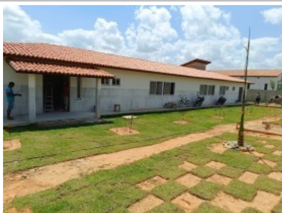
Vista da frontal da unidade de saúde
