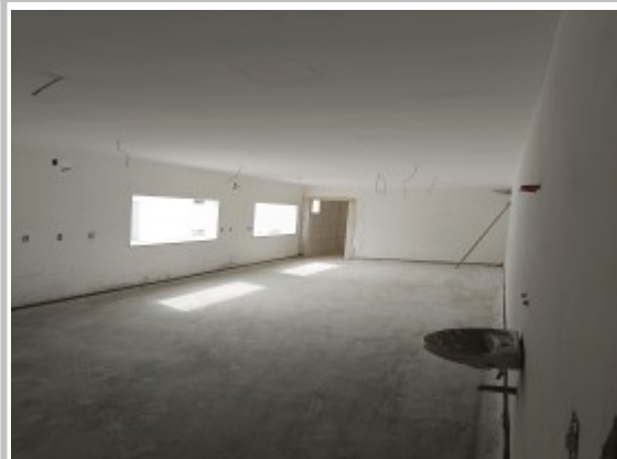
Vista interna, Sala em reforma
