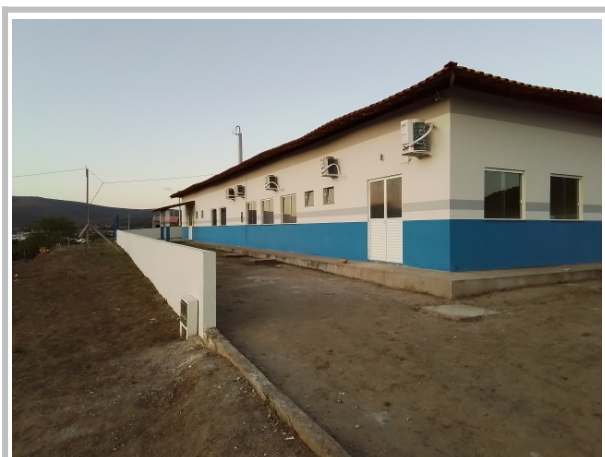
Vista externa da UBS (Frente)
