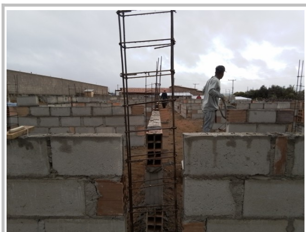
Obras em andamento (Vista dos fundos)
