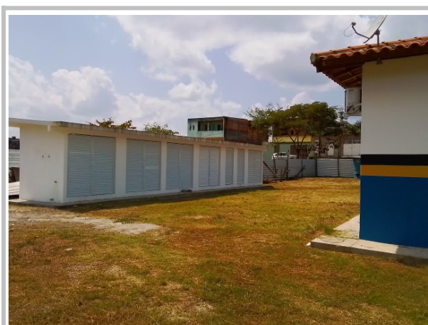
Abrigo de resíduos (Fundo da UBS)
