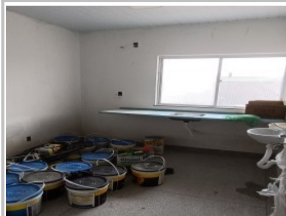
Obra em processo de pintura
