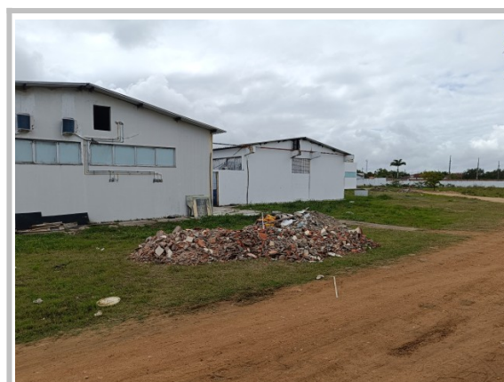
Vista do fundo do Hospital
