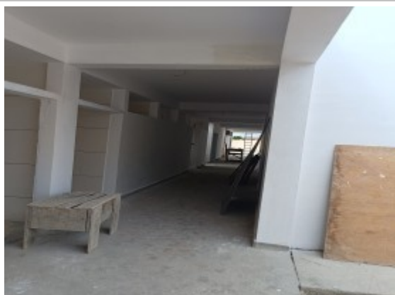
Vista interna, obras em execução
