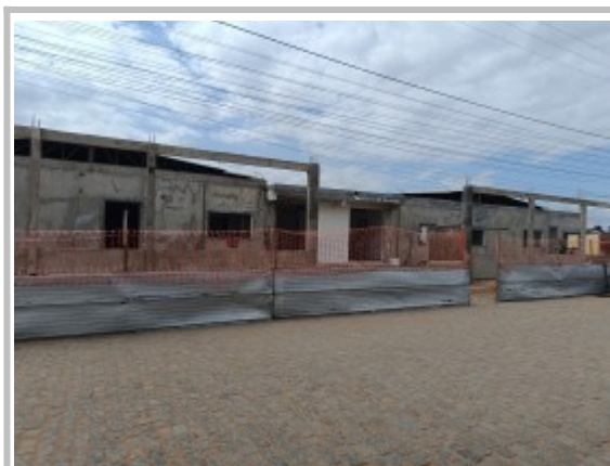
Vista frontal do Hospital em reformas
