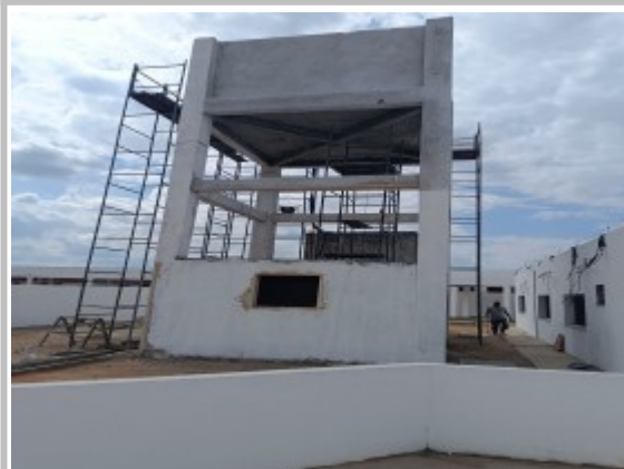
Compartimento de água, em conclusão
