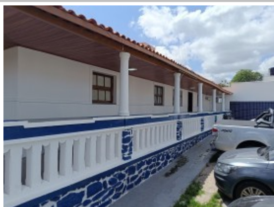
Fachada lateral do hospital concluída
