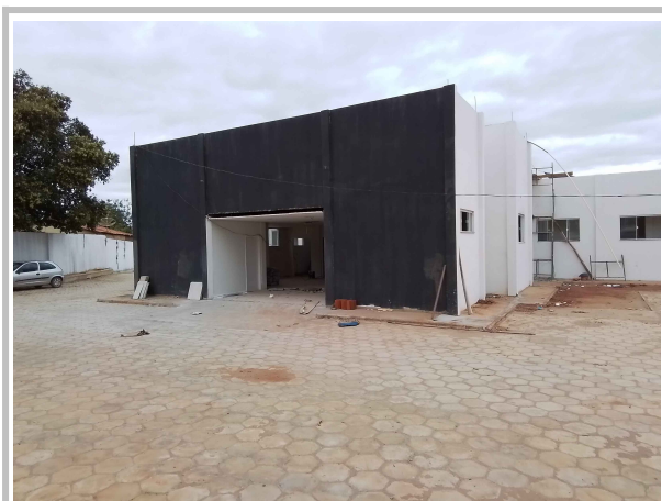
Vista frontal da Unidade de Pronto Atendimento - UPA no Município de Caetité
