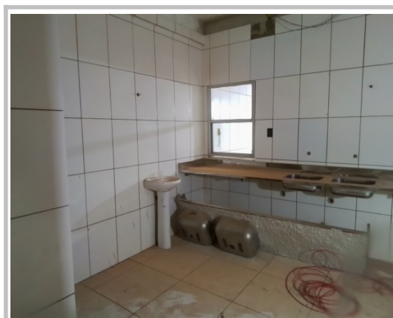
Instalação de pias em andamento
