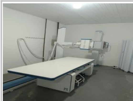
Sala de RX concluída e funcionando
