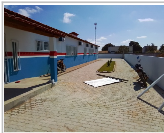
Vista externa da UBS (Frente)
