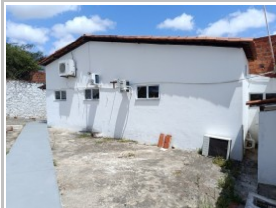
Vista do fundo do hospital
