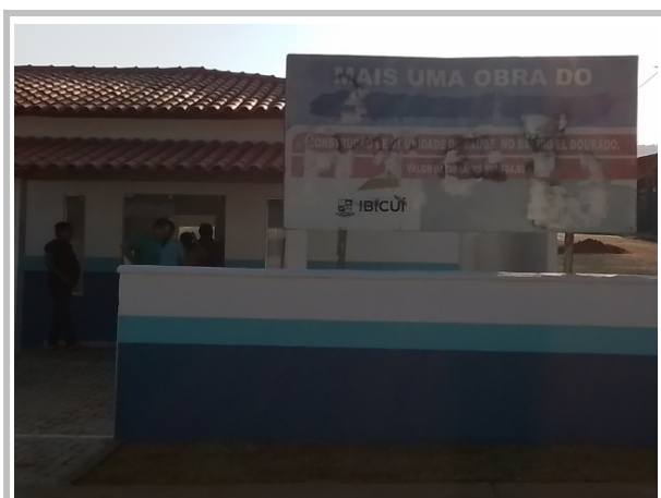
Placa de Identificação da Obra
