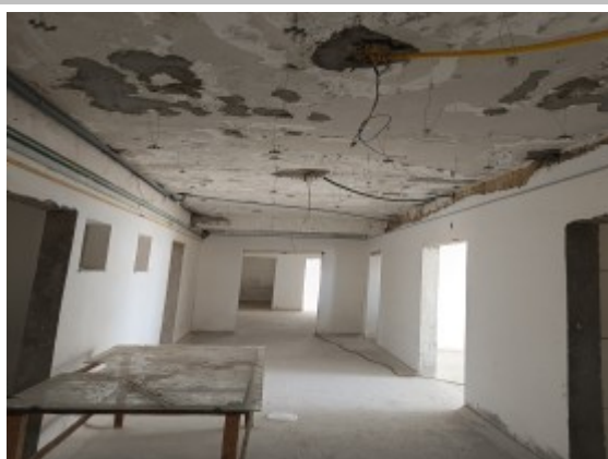
Vista interna da obra em execução
