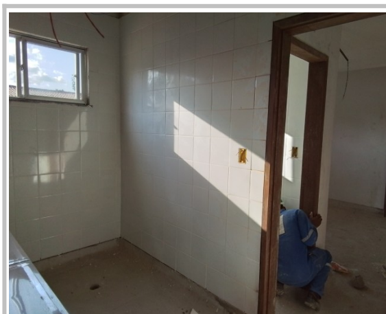
Obras de reforma em andamento
