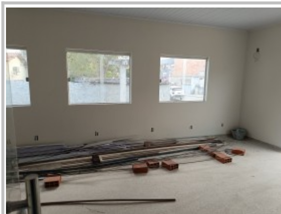
Vista interna da Sala de reunião em obras
